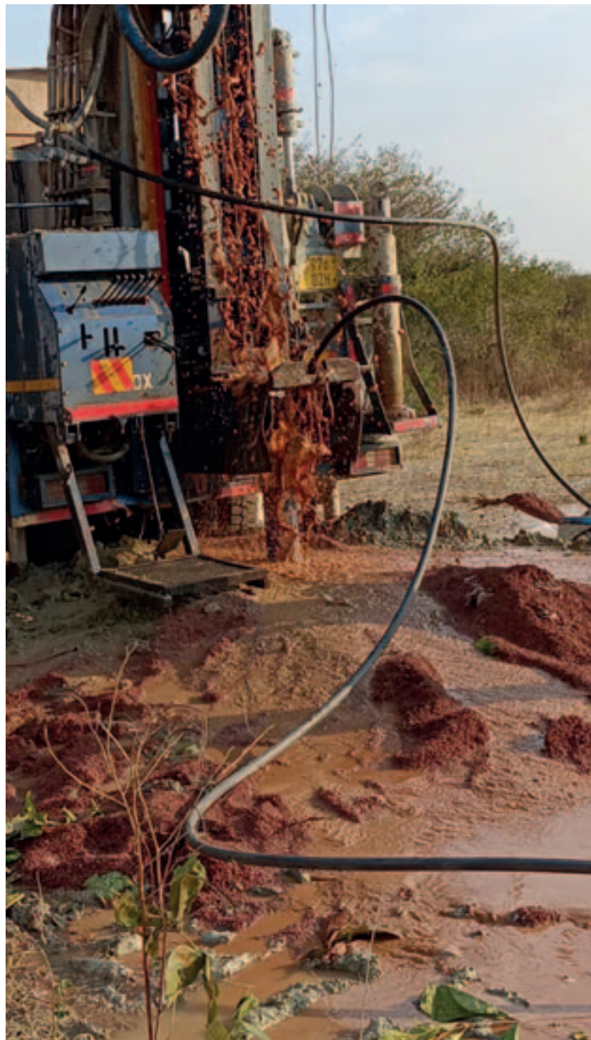
Perforazione del pozzo
