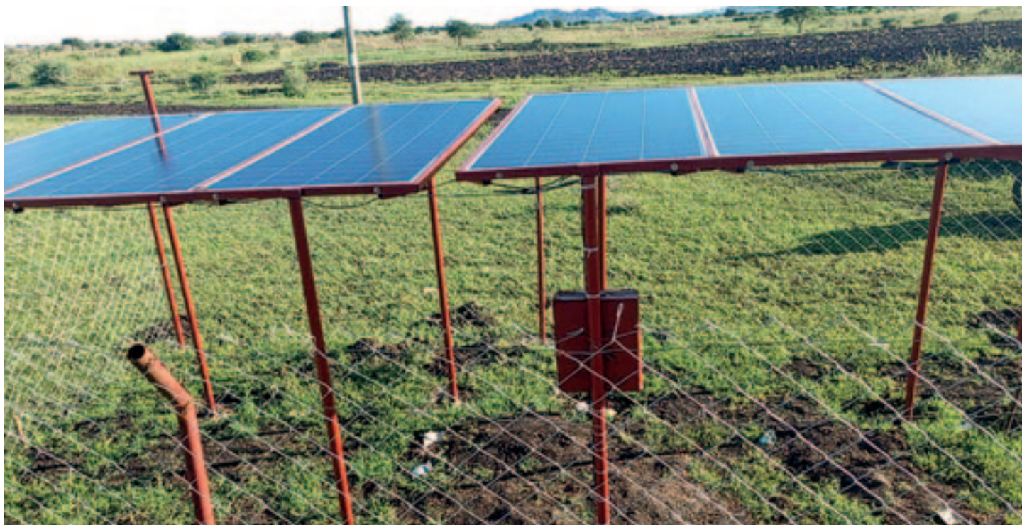
Pannelli solari che alimentano la pompa sommersa
